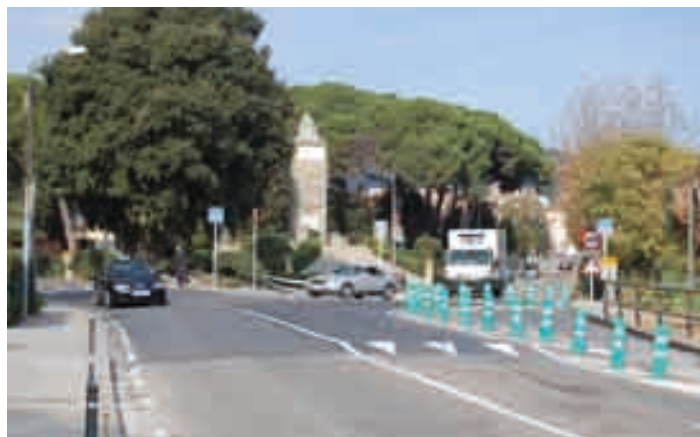
La cruïlla del monument al cardenal Vives, després de les obres.
