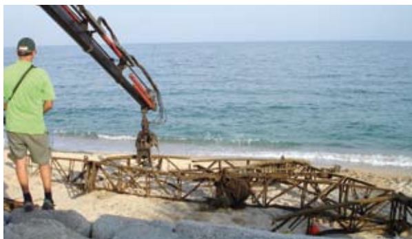
Extracció de l'estructura metàl·lica de la platja.
